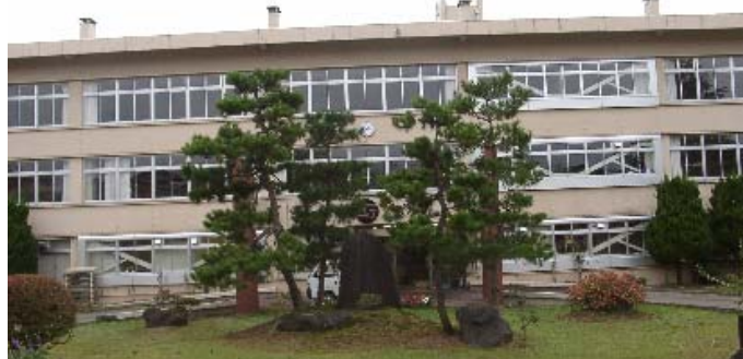
写真-1 耐震補強状況
