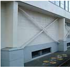
写真5 Nc9 ブレース
