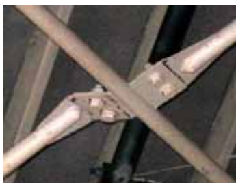
写真1 屋根面プレース
