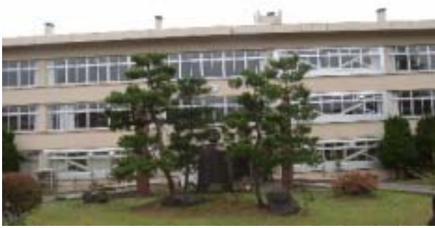
写真 - 1 耐震補強状況
