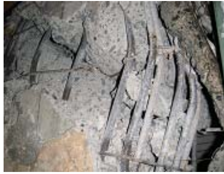
(c)柱南西面上部詳細
