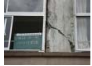
写真-4 2階柱A-4 (はつり後)
