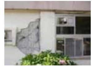
写真-6 1階柱型付壁 C-16~17
