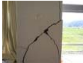
写真-5 2階柱A-4 (内観写真)
