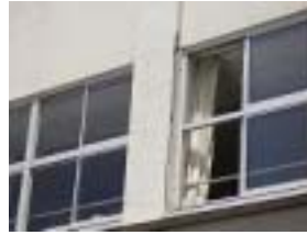
写真-3 2階柱A-4 (はつり前)
