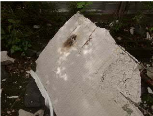
写真6 ALC版取り付け部(丸綱90度フック)
