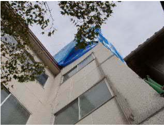
写真4 裏から回ってペントハウスを見上げた
