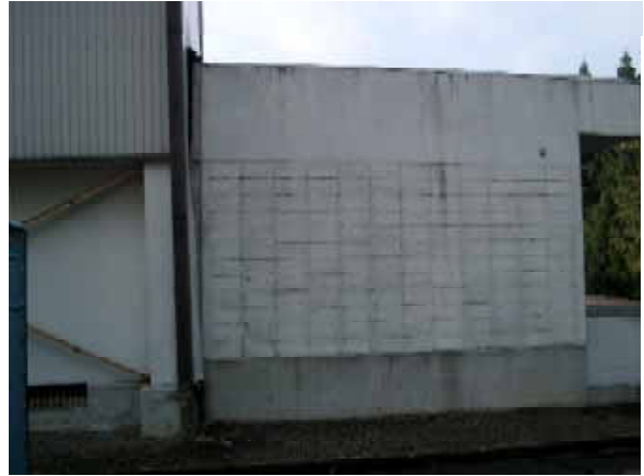
写真 - 7 体育館と下屋の状況
