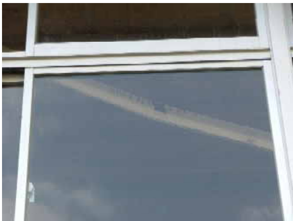
写真 - 1 2 壁面ブレースの座屈
