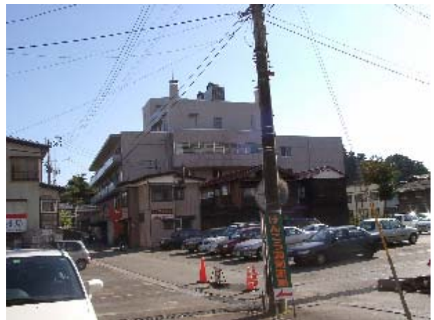
写真-5.18 水仙の家(免震建物)の全景(積層ゴム+すべり支承タイプ) : 事務長にお伺いしたら揺れたけど特に問題はなかったとのこと。ただし、電気、ガス、水道は周りが全部だめなので、やはりだめ。多少の蓄電分のみだったとのこと。1F は本館(この施設は前の写真の小千谷総合病院の分館)からの避難者でいっぱいだ
