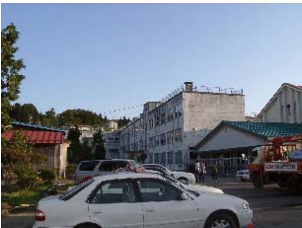
写真-5.1 小千谷小学校の正面全景：軽微、強震計(NIG019)の近くに建設されており、強震計は1308galを記録していた。
