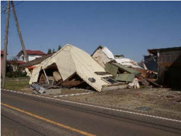
写真-5.23 崩壊した民家の車庫(小千谷市小栗田)
