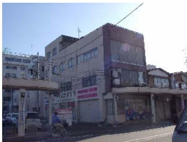
写真-5.21 291号の商店街の3FのRC造被害建物の全景：道路に沿った方向(東西方向)の被害が大きい。一番手前の柱の詳細は次写真。
