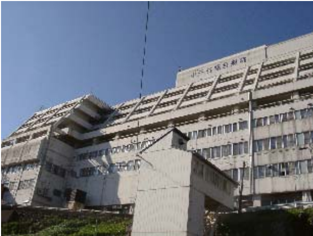
写真-5.14 小千谷総合病院 (RC 造約 7 階) の全景(南側) : 3F 以上ではスプリンクラー故障で水浸しののために使用できないそうだ。
