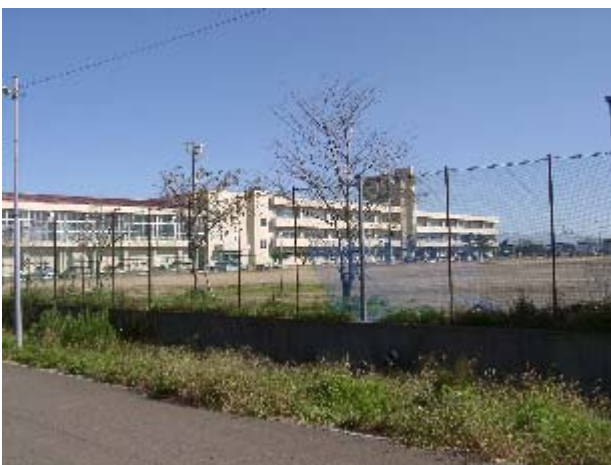
写真-3.1 分水北小学校 - 校舎、被害なし。
