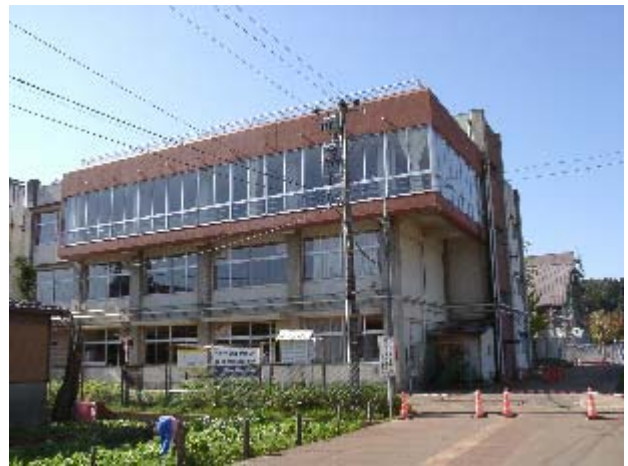
写真-4.1 与板小学校 - 校舎：被害なし。
