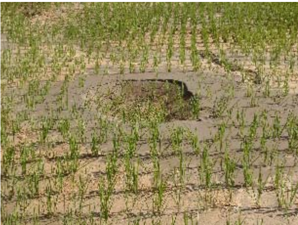
写真-3.4 河川敷の田んぼの液状化跡
