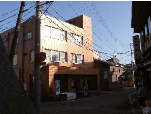
写真-5.30 自動販売機の転倒：自動販売機が道路の真ん中まで転倒し、その後手前に戻した
