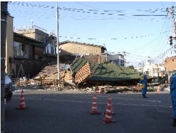
写真-5.29 木造住宅の崩壊(元町交差点)
