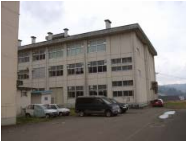
写真-61 十日町総合高校工業科棟の外観。北側も通常の柱でラーメンが構成されている。めだった被害は見られなかった。
