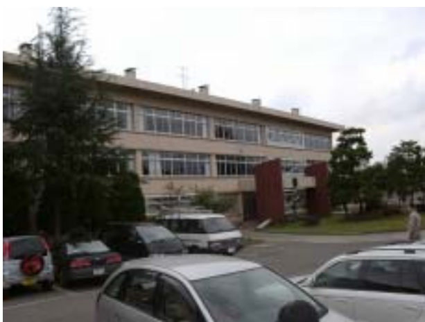
写真-44 十日町総合高校管理棟の外観。エントランスの車寄せ部でわずかなコンクリートの損傷がみられた。（詳細次の写真）
