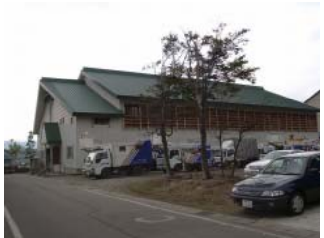
写真-43 十日町高校東体育館の外観。被害はみられなかった。軽微。
