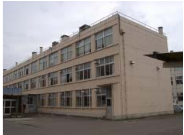
写真-59 十日町総合高校特別教室棟の外観。特別教室棟も同様の構造になっているが補強されていない。この棟でも北側の柱にせん断ひび割れがみられた（詳細は次の写真）。
