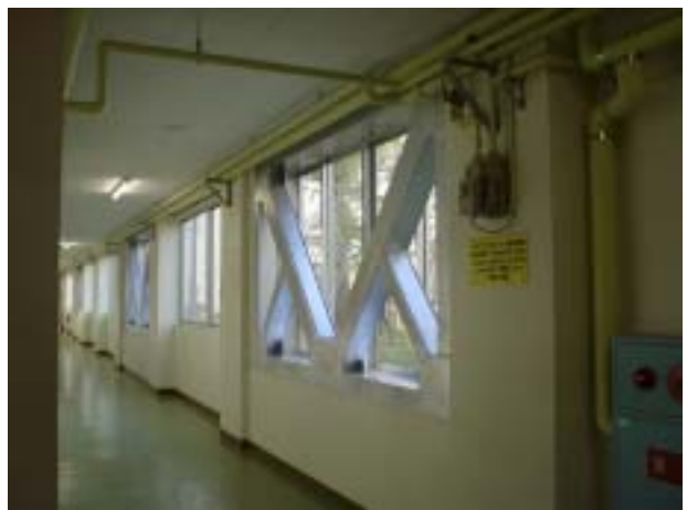
写真-38 K ブレース補強を内部からみたところ。
