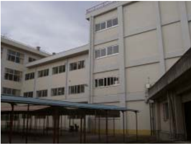
写真-39 十日町高校第1棟と第2棟を繋ぐ渡り廊下棟（RC3F）の外観。
