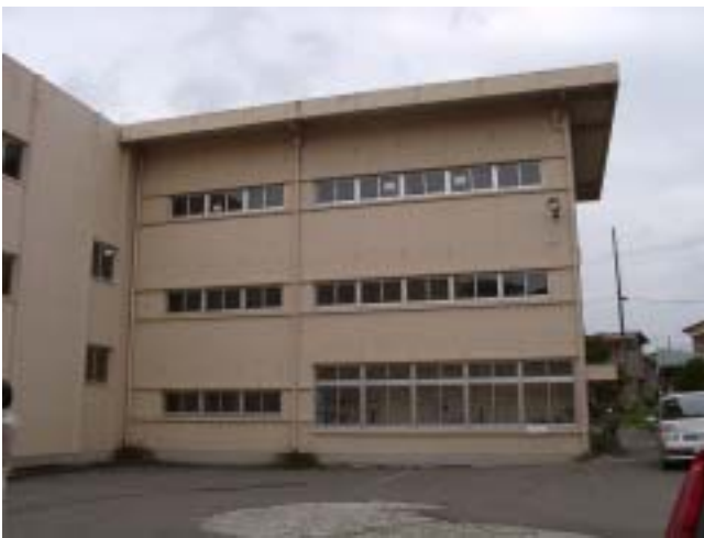
写真-49 十日町総合高校管理棟の西側部分を北からみた外観。建物の北側は、ウォールガーダーにとりつく扁平な柱であり、極脆性柱である。これらの柱のほぼ全部にせん断ひび割れが観察された。1Fの中央の短柱の外からと内からの写真、および、その隣の階段室とのつなぎ目の柱の被害を次に示す。
