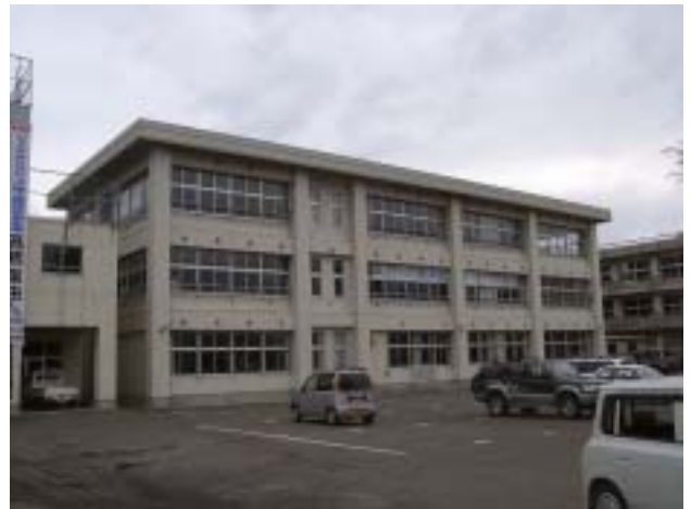
写真-22 南中学校特別教室棟(RC3F)外観。被害は軽微。
