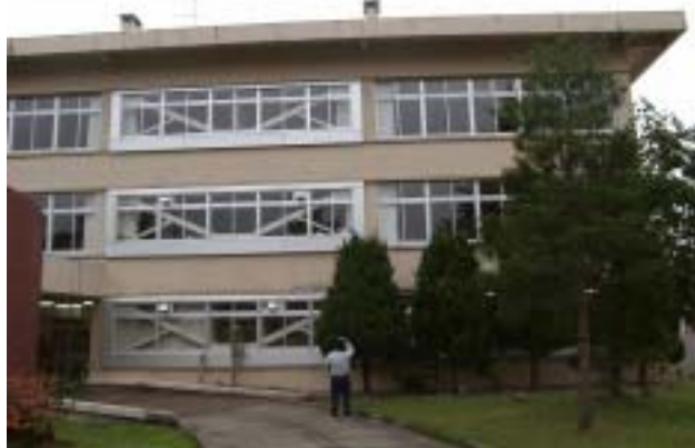
写真-46 十日町総合高校管理棟の K 型補強プレースの状況（南面）。
