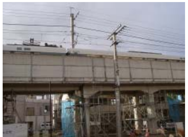
写真-80 ほくほく線の特急はくたか号が徐行運転で通過していた。
