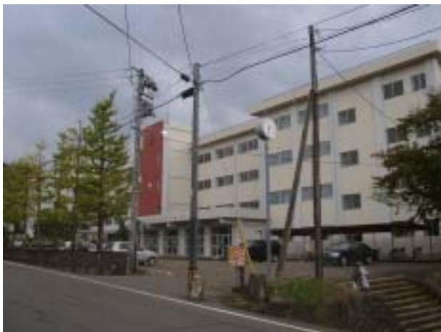
写真-34 十日町高校第 2 棟 ( RC4F,補強済み ) の北面の外観。被害は軽微。
