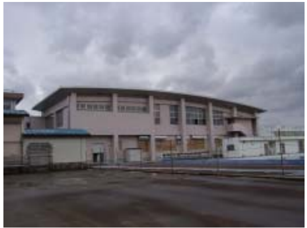
写真-31 十日町中学校給食室棟の外観。軽微。
