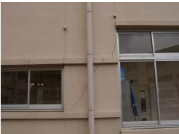
写真-49 十日町総合高校管理棟の西側部分を北からみた外観。建物の北側は、ウォールガーダーにとりつく扁平な柱であり、極脆性柱である。これらの柱のほぼ全部にせん断ひび割れが観察された。1Fの中央の短柱の外からと内からの写真、および、その隣の階段室とのつなぎ目の柱の被害を次に示す。
