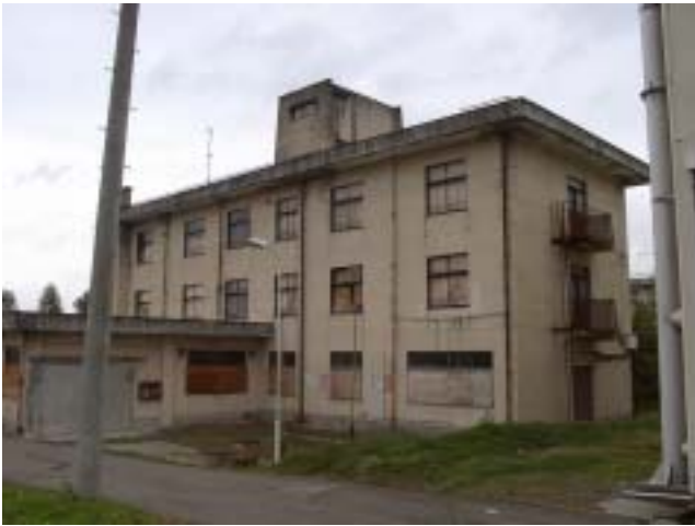
写真-24 南中学校旧校舎棟（西北側の棟、RC3F）の外観。教室等としては使われていない。被害は軽微。
