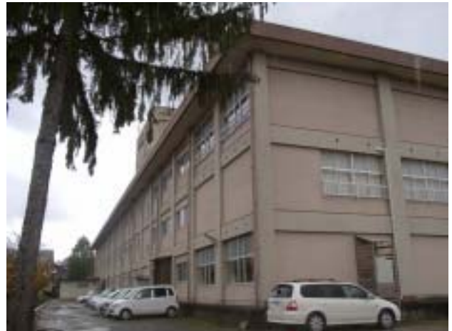
写真-7 川治小学校外観（管理普通教室棟、この建物の奥に直線状に、特別教室棟と、給食棟が連なる。）
