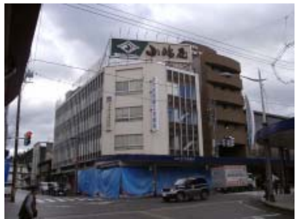
写真-64 十日町商工会議所の外観。大破。
