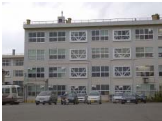
写真-37 十日町高校第 1 棟の外観。連層の K ブレースにより補強がなされていた。
