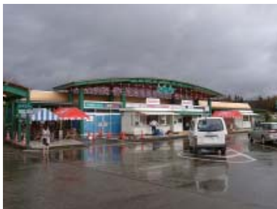
写真-86 関越道、越後川口のサービルエリアの 建物は天井落下などで使用不能。
