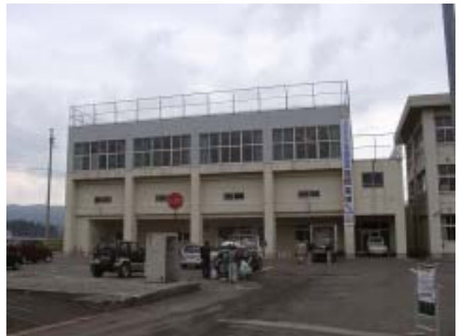
写真-23 南中学校柔剣道場(RC2F)の外観。3Fはブレースがある。被害は軽微。
