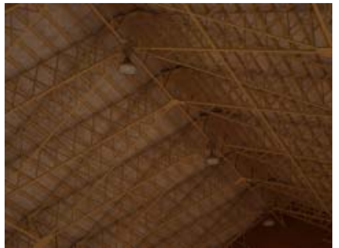
写真-27 南中学校体育館の屋根構造。
