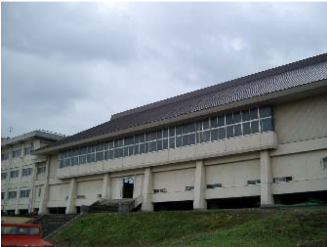
写真-25 南中学校体育館の外観。その向こうに見えるのは管理普通教室棟の北側の棟の外観。両建物とも1Fに階高の低いピロティ形式になっている。体育館は妻部外壁仕上げ材と1層RC部に軽微被害が観察された。また、4つの桁行きブレースの内1つに座屈がみられた。詳細は以下の写真に示す。
