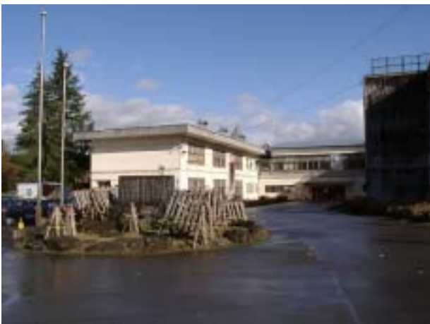
写真-1 十日町小学校外観(左:管理棟(2F)、右:普通教室棟(3F))。右の普通教室棟と中央の渡廊下
