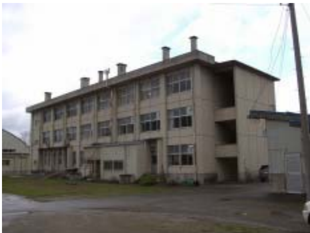
写真-62 十日町総合高校農業科棟の外観。北側も通常の柱でラーメンが構成されている。めだった被害は見られなかった。
