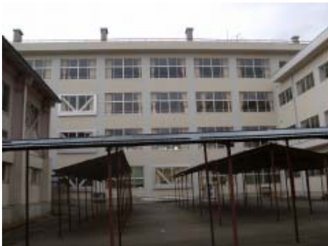
写真-35 十日町高校第 1 棟の南面の外観。左に格技場が見える。
