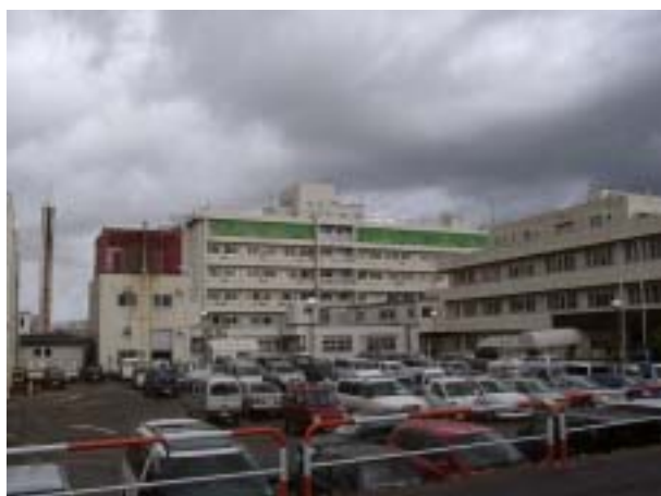
写真-71 十日町病院の全景。右側が比較的新しい診療伊藤。中央が病棟。
