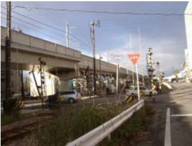
写真-77 北越急行十日町駅近くの踏切を越える高架橋（十日町駅付近）。向こう側に見えるのが十日町駅。
