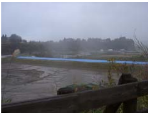
写真-85 浅河原川の調整池の水が枯れていた。 下流側。
