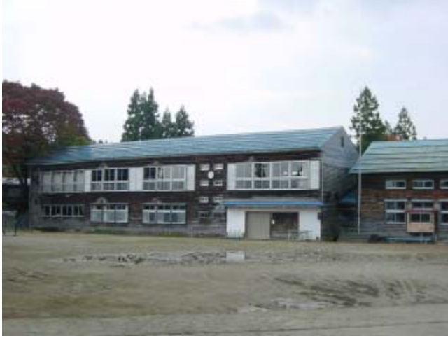
写真1. 木造校舎（左側屋根が湾曲）
