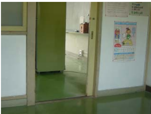
写真6 . 1階床の変形
