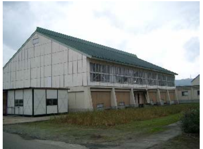
写真-36 十日町総合高校体育館の外観。目立った被害は見られなかった。
