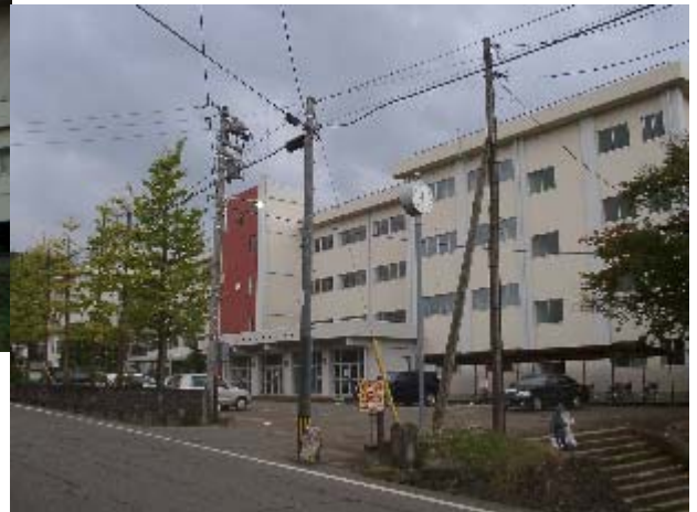
写真-14 十日町高校北側棟（RC4F,補強済み）の北面の外観。被害は軽微。
