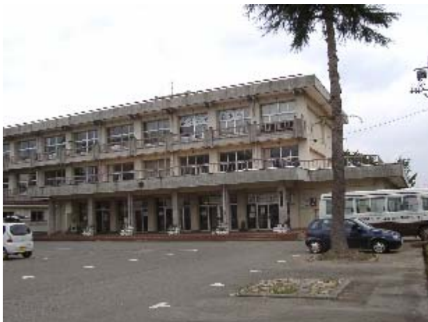
写真-8 南中学校東側の棟 (RC3F) の外観。被害は軽微。
