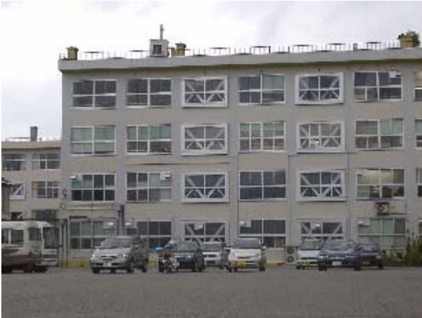
写真-17 十日町高校南側棟の外観。連層の K ブレースにより補強がなされていた。
