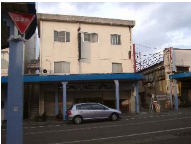
写真-42 コモ通り商店街の建物（S 造3F）の外観。
