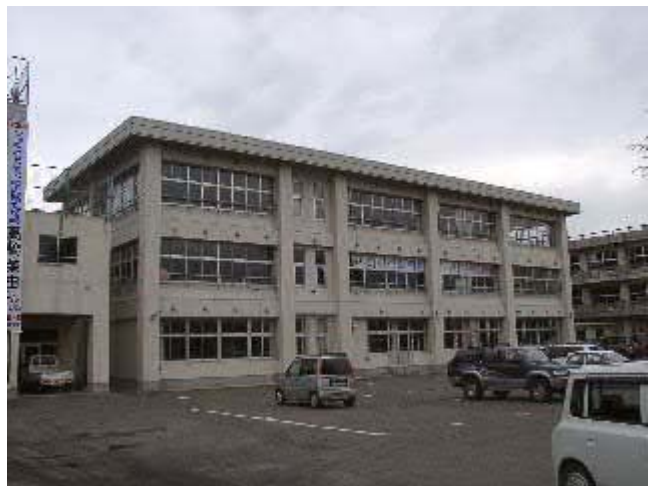
写真-9 南中学校南側中央の棟 (RC3F) 外観。被害は軽微。
