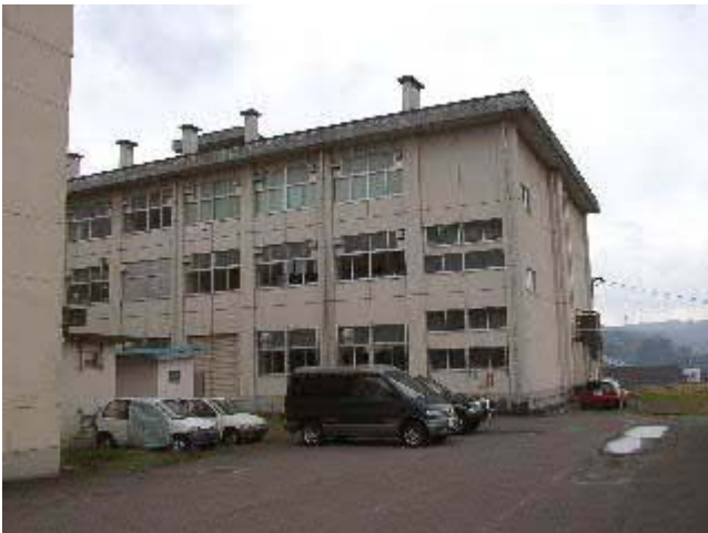
写真-35 十日町総合高校西側の棟の外観。めだった被害は見られなかった。
