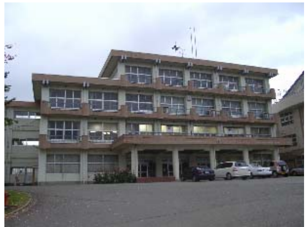
写真-48 川西中学校管理棟 (RC 4 F) の外観。被害は軽微。
