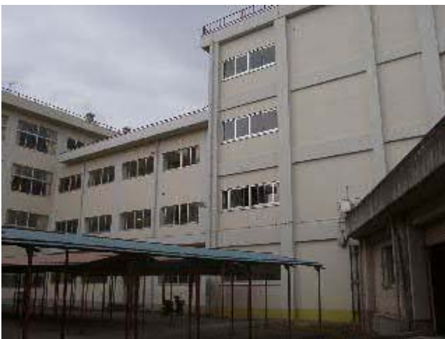
写真-19 十日町高校南側棟と北側棟を繋ぐ渡り廊下棟（RC3F）の外観。
