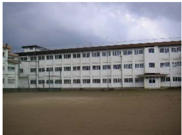
写真-49 川西中学校一般の教室棟 (RC 3 F) の外観。被害は軽微。
