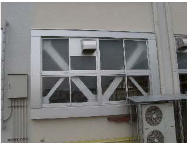
写真-18 K ブレース補強の詳細。
