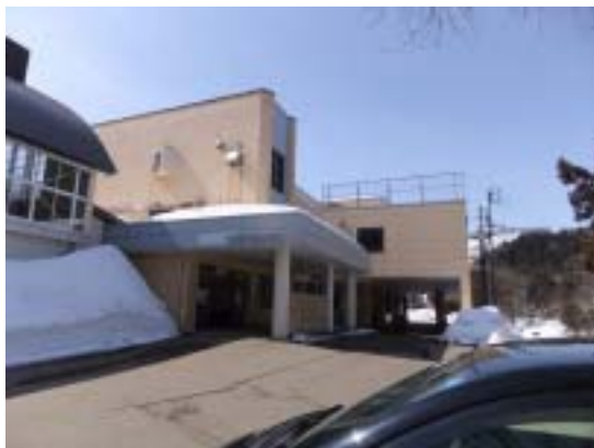
写真3 安塚やすらぎ荘北東全景(エントランスの無効に見える2階の建物は鉄骨造(H11年建設)の増築部分。)
