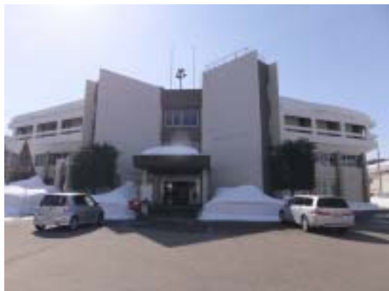
写真1 安塚区総合事務所(補強済み、周辺地域を含めて被害は見あたらない)
