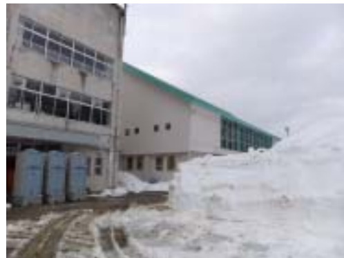
写真 60 松里小学校体育館
