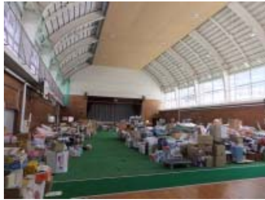
写真 14 安塚やすらぎ荘の体育館の内部(被害は見られない)
