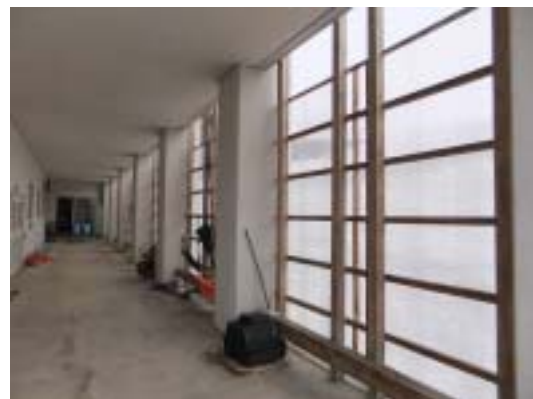
写真 38 津南町上郷小学校体育館の1階のRC部分（被害は見られない）
