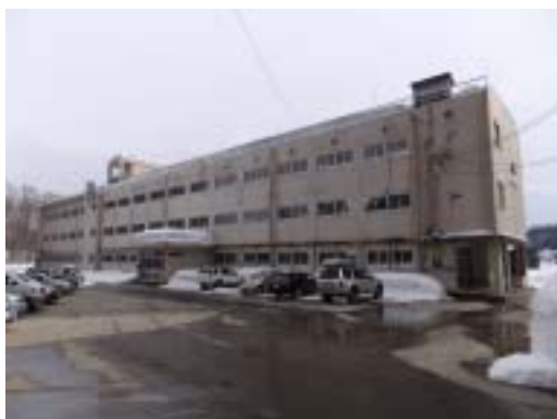
写真 48 松之山中学校 RC 造校舎の廊下側全景
