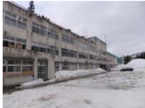
写真 58 松里小学校 RC 造校舎の全景
