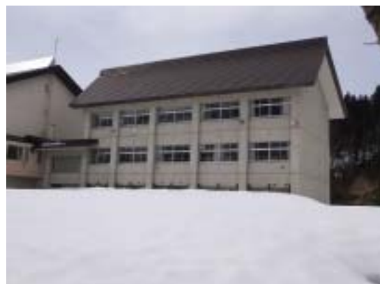
写真 28 津南町上郷中学校 RC 造校舎 (被害は見られない)
