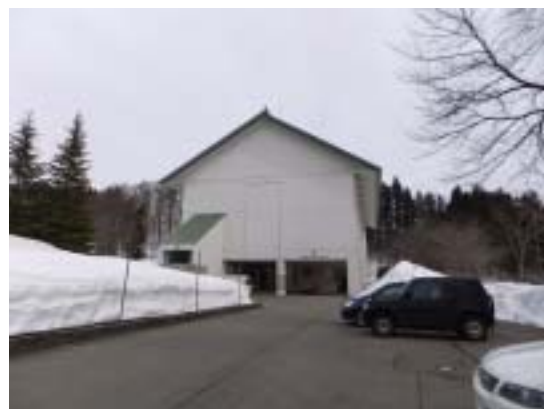
写真 30 津南町上郷小学校体育館妻面
