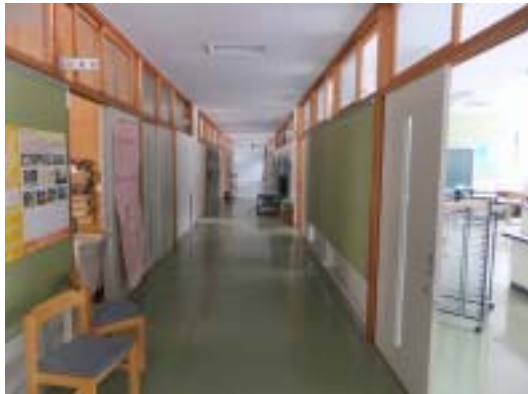
写真 39 津南町上郷小学校 RC 造校舎（被害は見られない）
