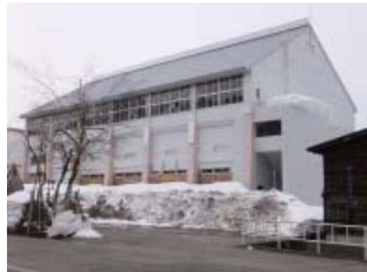
写真 42 津南中等教育学校の RSc1 タイプの体育館
