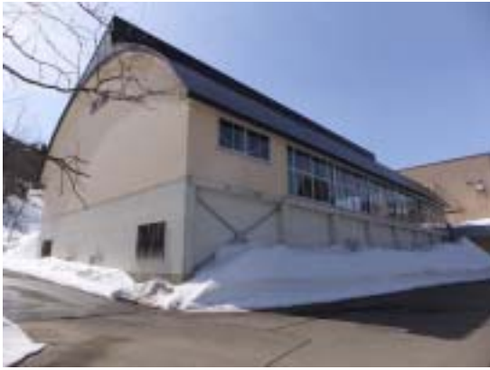
写真 13 安塚やすらぎ荘の体育館(被害は見られない)
