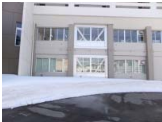
写真2 安塚区総合事務所(K ブレースによる補強)
