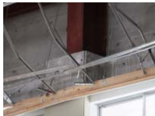
写真 36 津南町上郷小学校体育館の鉄 骨屋根支持位置の鉄骨
