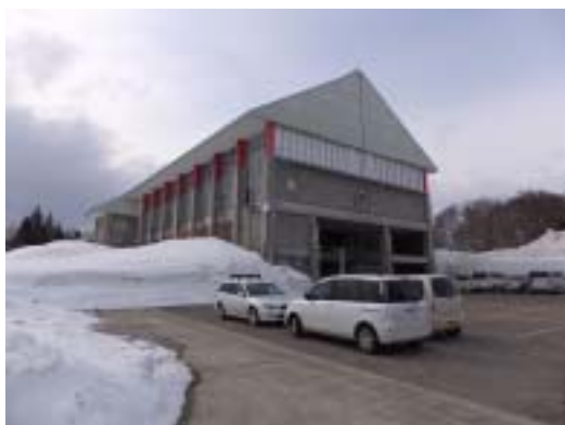
写真 47 松之山小学校の RSc1 タイプの体育館（校舎無被害も設備機器に損傷との話）
