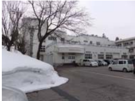
写真 45 津南中学校の RC 造校舎
