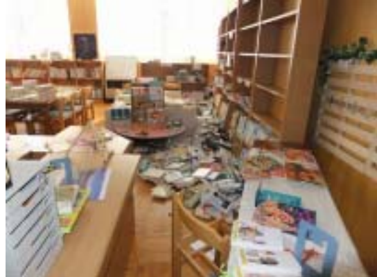
写真 40 津南町上郷小学校 RC 造校舎の図書室（図書の散乱が見られる）
