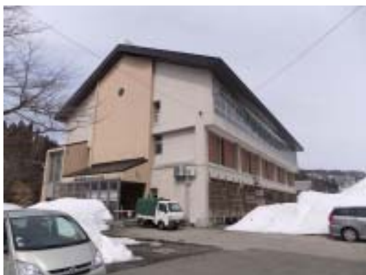
写真 19 津南町上郷中学校体育館南面 全景(構造体には被害は見られない)
