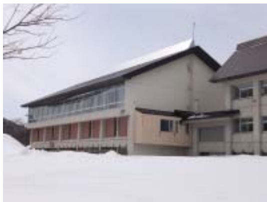
写真 20 津南町上郷中学校体育館東面 全景(構造体には被害は見られない)
