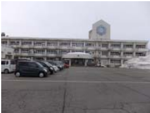
写真 44 津南中学校の RC 造校舎
