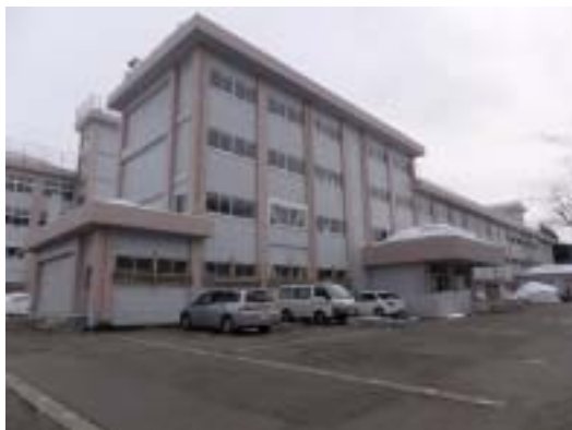
写真 41 津南中等教育学校の RC 造校舎群（補強済み、被害は見られない）
