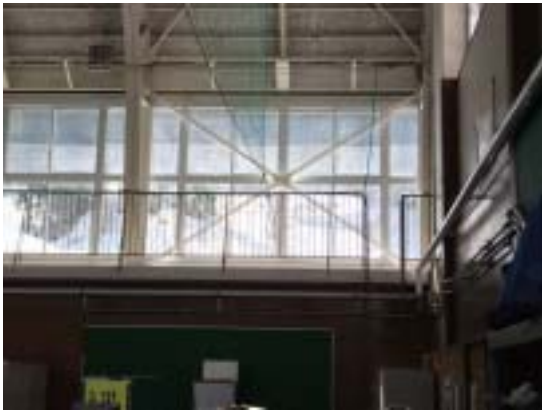
写真 15 安塚やすらぎ荘の体育館のブレース(被害は見られない)
