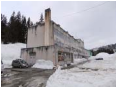
写真 57 松里小学校 RC 造校舎の全景
