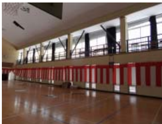
写真 22 津南町上郷中学校体育館内部 (プレースの被害は見られない)
