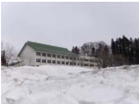
写真 29 津南町上郷小学校体育館 (手前) と RC 造校舎南面全景 (構造体には 被害は見られない)
