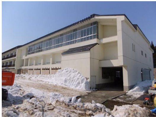
写真 37 北信小学校の体育館棟の南側の全景（避難所として使われている、1階は外部となっているが、その柱には損傷が見られていない）
