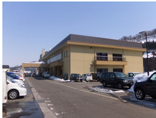
写真 22 栄村村役場 (3 階建ての 2 階部分が見える)
