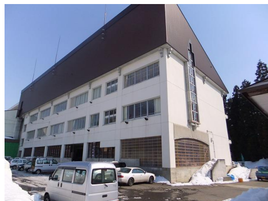
写真 24 長野県栄村北信小学校 RC 造教室棟の廊下側全景 (梁間方向はほぼ同じ長さの 2 スパンが基本で、廊下側の 1 スパンの半分は外部となっている。その外部と廊下の間は小さな柱や雑壁が配置されている。)
