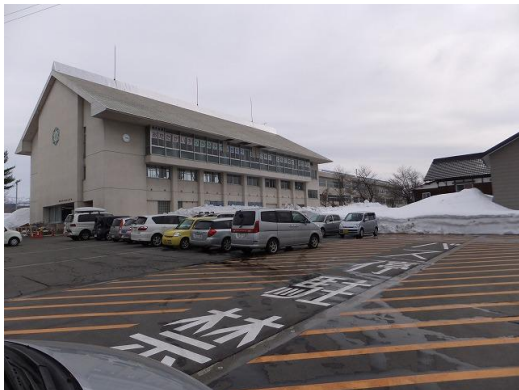
写真 1 津南小学校のRSc1タイプの体育館とその向こうに RC 造校舎
