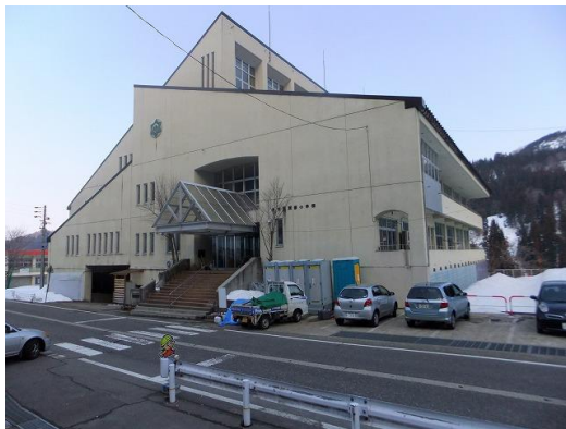
写真 42 長野県栄村東部小学校（RC 造+S 造）の全景。RC 造 3 階の 2 階 3 階の一部に片流れ屋根の S 造体育館が一体となって取りついている。閉校予定。
