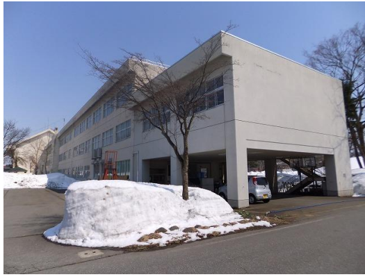
写真 19 津南小学校の 3 階建て RC 造校舎
