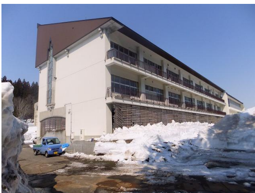
写真 23 長野県栄村北信小学校 RC 造教室棟の教室側全景。一部の柱にせん断ひび割れがみられたが、梁降伏型の全体崩壊系のメカニズムになっている。
