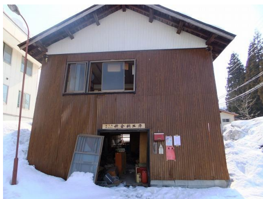
写真 38 北信小学校の近くの集会所が傾いている
