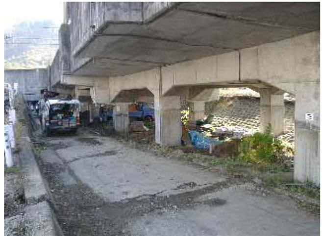
写真-5 トンネル出入口方面の写真。上の斜面となっていて、橋脚はトンネルに近づくにつれ、地表面上に見える部分は短くなっていく。また、橋脚は線路方向に3スパンラーメン、その直交方向に1スパンラーメンとなっていた。
