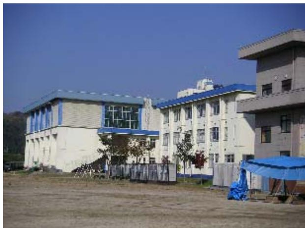
写真-13 川口小学校校舎の外観：手前が新しい校舎、奥は上部が体育館となる校舎でそれぞれがEXP.Jで接続されている。
