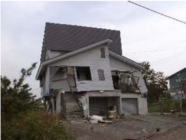
写真-2 A宅の外観2。上部の木造部分の傾き、木造家屋の基部と高床式の基礎がずれていることが分かる。
