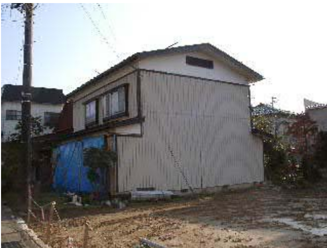
写真-46 Q宅の外観。布基礎と束による独立基礎の組み合わせになっている。手前の束がはずれていた（詳細は次の写真）。
