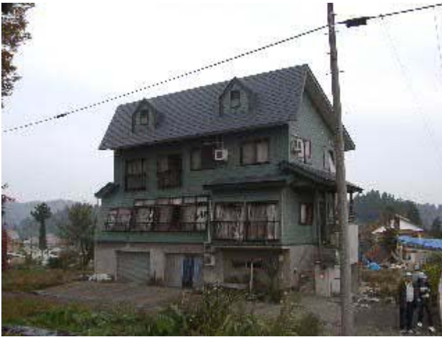
写真-12 B 宅の外観 2。開口が多いことがわかる。すなわち、筋交いなどを配している壁が足りなかった可能性がある。
