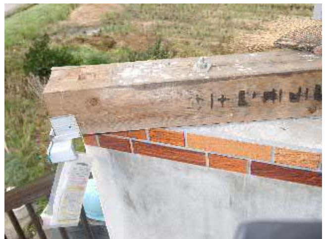
写真-6 A宅の1階の土台。前の写真の柱に対応するほぞ穴がみえる。
