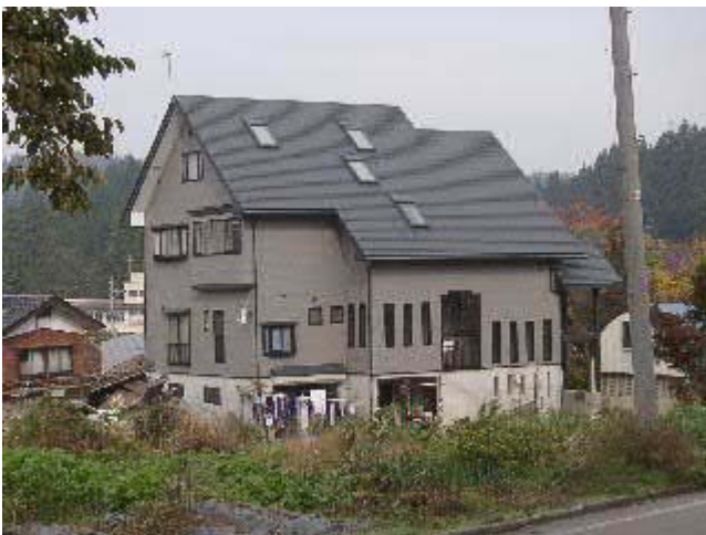
写真-14 C 宅の外観。鉄筋コンクリート造の高床式住宅で、軽微な被害と思われる。
