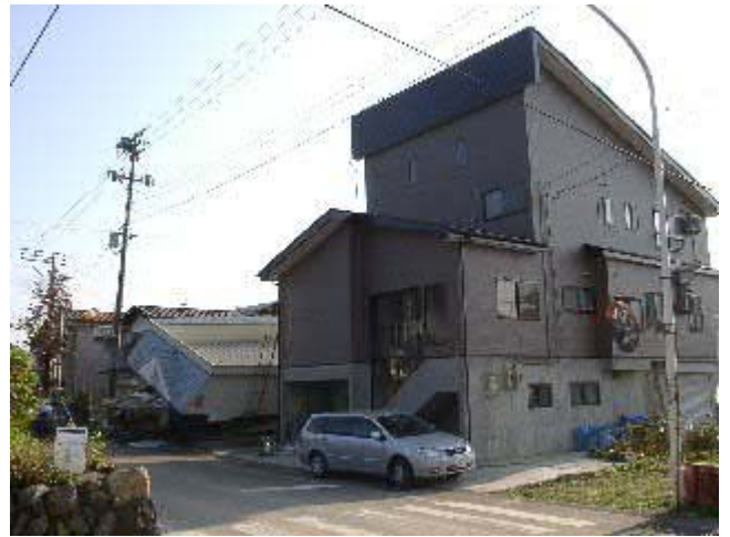
写真-58 Y1宅（右、高床式住宅、被害軽微）とY2宅（左、高床式住宅ではない、倒壊）。
