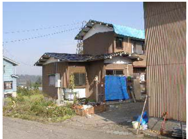
写真-31 J 宅の外観。次の写真に基礎を示すが、無筋コンクリートと思われる。
