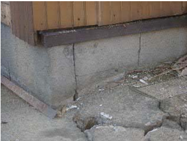
写真-51 S宅の基礎。布基礎であるが、無筋コンクリートと思われる。この種類の基礎も古い建物に多い。ブロックのようにばらばらになってしまい、上部構造もばらばらに震動する。
