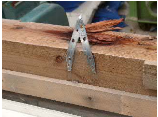
写真-21 D 作業場の土台。柱があった位置。山形プレートがみえるが、金物しては貧弱であり、柱は抜けている。
