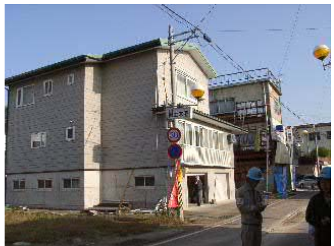
写真-43 O宅。高床式住宅。被害軽微と思われる。
