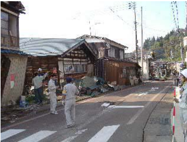
写真-38 主要地方道小千谷 - 川口 - 大和線の道路の被害 1、この道路に沿った被害が大きい。
