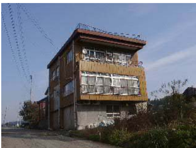
写真-35 L 宅の外観。高床式であるが、1 階は鉄骨造である。
