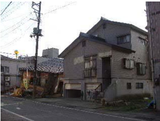
写真-57 X1宅（右、高床式住宅、被害軽微）とX2宅（左、高床式住宅ではない、倒壊）。
