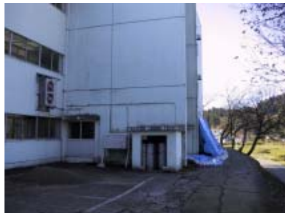
写真10 地盤が沈下した西側部分。右側が崖になっており、この部分が崩れた。なお、直接基礎であるが、建物の傾斜は約 1/170\text{rad} と少ない。
