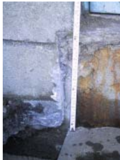
写真10 地盤が沈下した西側部分。右側が崖になっており、この部分が崩れた。なお、直接基礎であるが、建物の傾斜は約 1/170\text{rad} と少ない。
